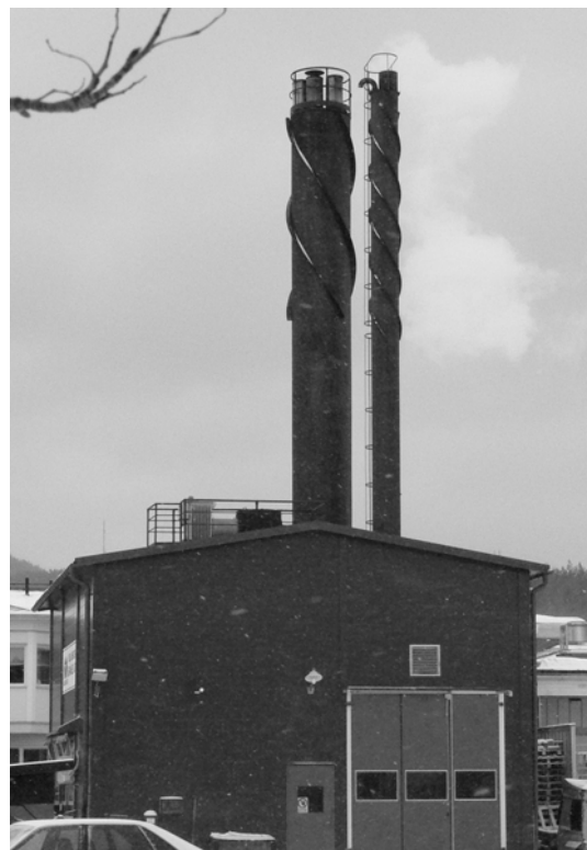
Fjärrvärmeverket i Bergsjö
