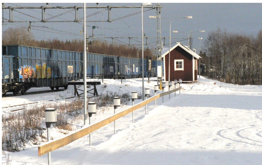
Motorvärmare vid tågstationen i Gnarp
