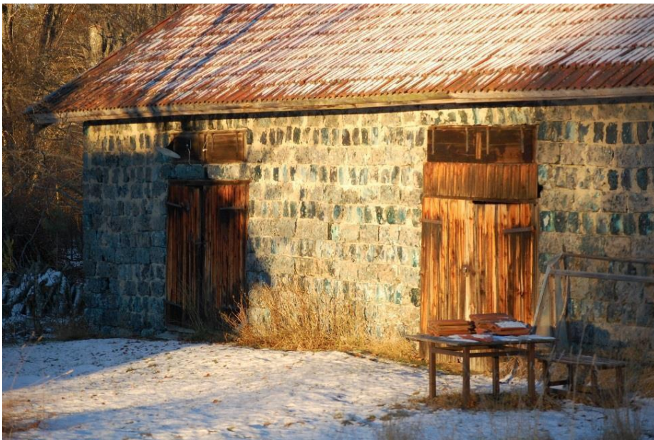
De två största uthusen till arbetarbostäderna har denna utformning med slaggstensväggar.
