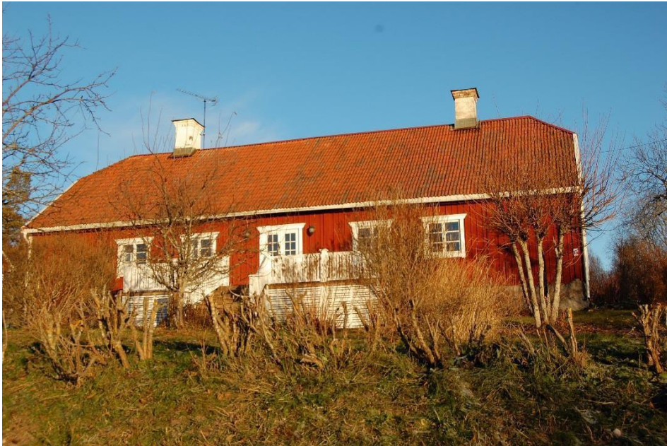
Gnarps Masugn 1:57, storbyggningen
