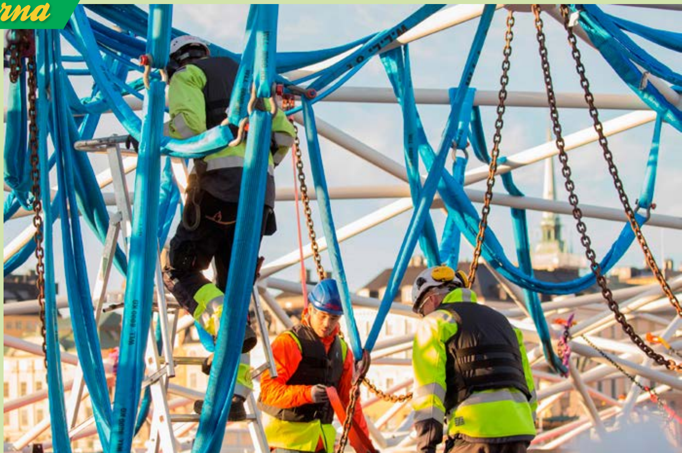
Sjölins smide levererar och monterar tak-konstruktionen till renoveringen av Nationalmuseum.
